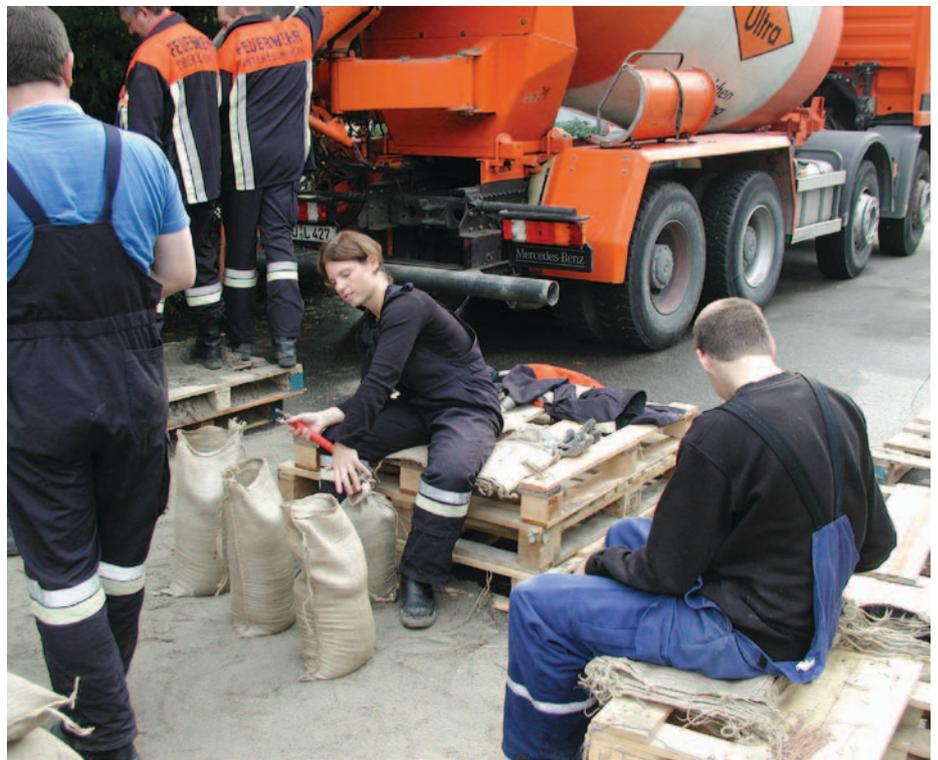
Beim Hochwasser August 2005 wurden mehrere Betonmischer einer Firma aus dem Raum Neu-Ulm zum Befüllen von Sandsäcken herangezogen.
